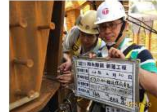
電焊前 開槽角度、Gap等查驗
