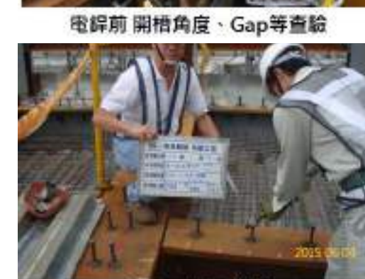
剪力釘敲擊檢測
