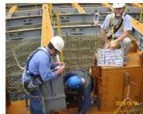
電焊後 會同第三者進行 NDT檢測
