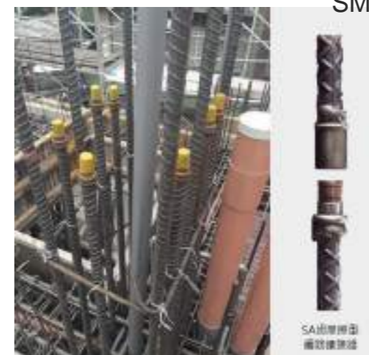
SA級鋼筋續接器
